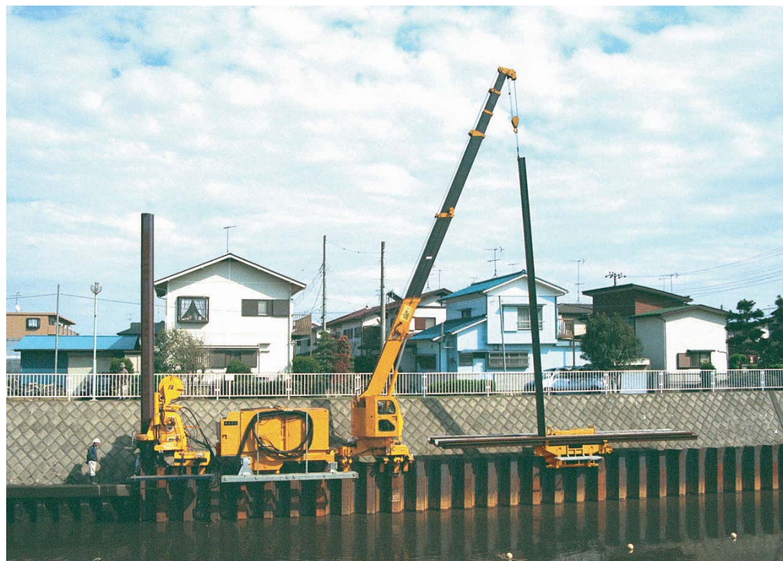
ノンステージング工法による住宅地での治水対策工事
