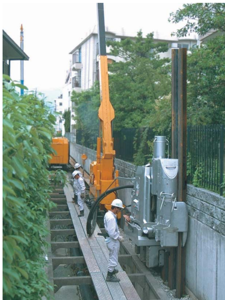
ゼロクリアランス工法による狭隘地での下水道築造工事
