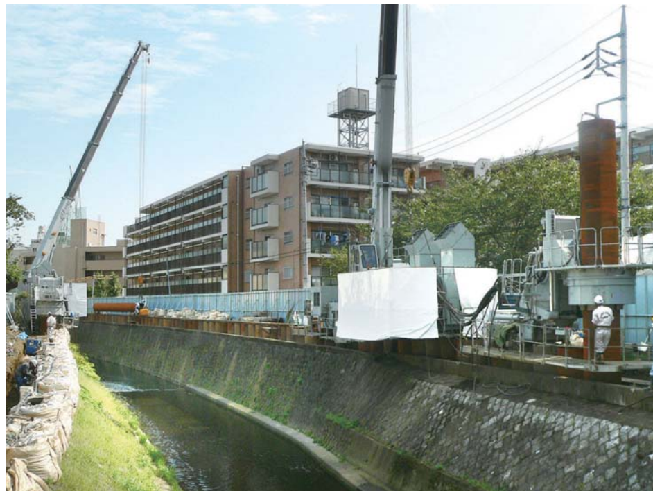
ジャイロプレス工法による住宅地での河川護岸整備工事
