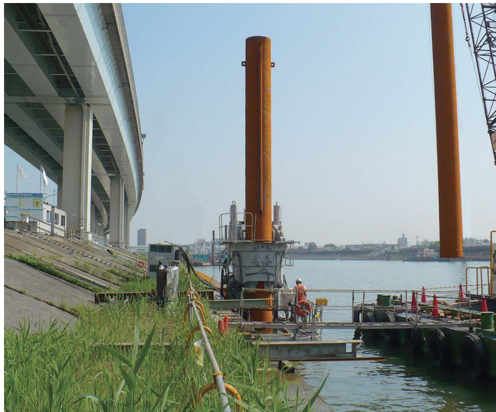
鋼管矢板圧入工法による高速道路に近接した都市河川護岸工事
