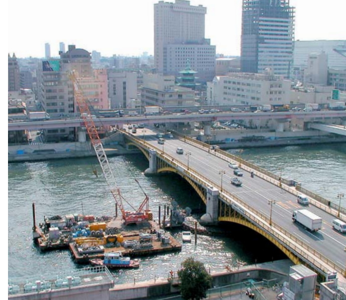
橋脚基礎耐震補強工事
